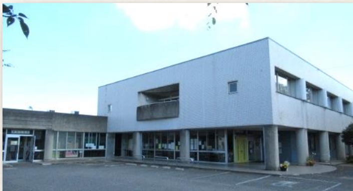
▲東金子地区センター(令和5年4月設置)
