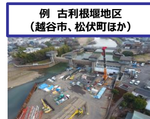
農業水利施設の耐震補強の前倒し
