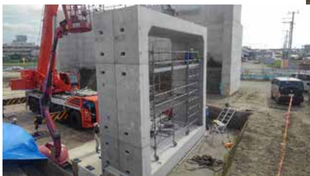
4分割 PRC ボックスカルバート 6500×5500 mm、L=24.640m 三郷流山橋 函渠工
