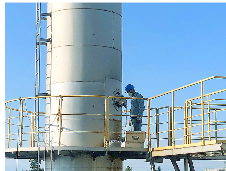
写真13-4 排出ガス中のダイオキシン類濃度の測定
