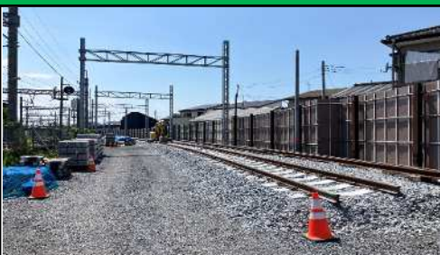
野田線89号踏切道 軌道工事施工中
