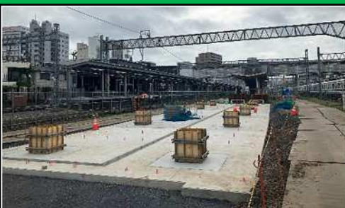
仮ホーム基礎工事 施工状況
