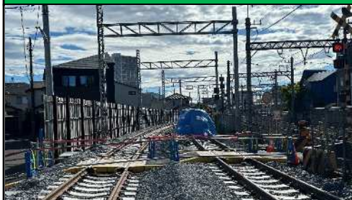
野田線88号踏切道 軌道工事施工中
