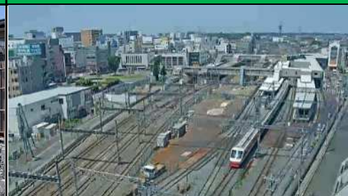
春日部駅構内工事施工状況
