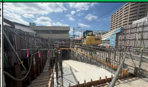
地下道コンクリート工事 施工状況
