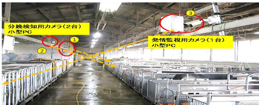
図1 豚舎内システム設置の様子 (母豚上方より撮影→小型PCへ転送→サーバーに保存→行動解析→農家の携帯に通知)
