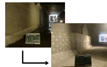
中継ポンプ場耐震工事 (壁部分等の補強)
