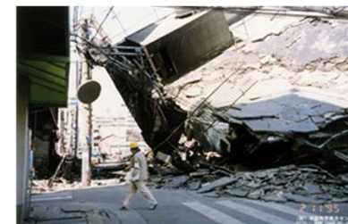
阪神・淡路大震災 出典(一財)消防防災科学センター
