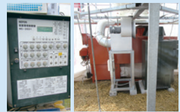
統合環境制御装置及び運動する機器 (Co2 施用システム)
