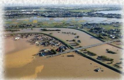
令和元年東日本台風で河川が氾濫（東松山市）
