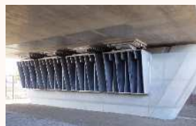
橋りょうの耐震化
