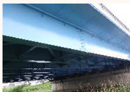
橋りょう修繕
