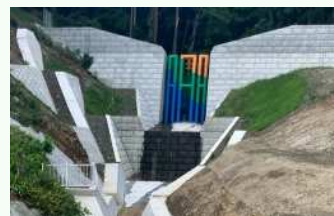
砂防関係施設整備
