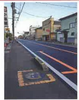
県道328号 金明町鳩ヶ谷線 道路(標識)の補修
