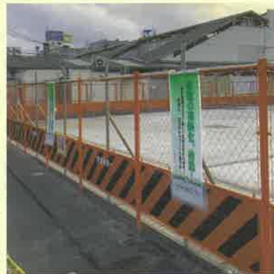
▲解体撤去工事が完了した春日部駅東口改札前テナントビル
