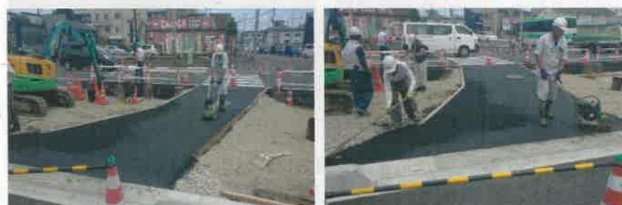
(6.26 柳島交差点改修工事)
