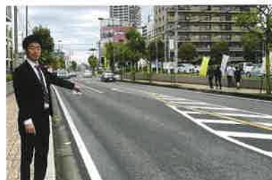
■県道266号の改修工事
