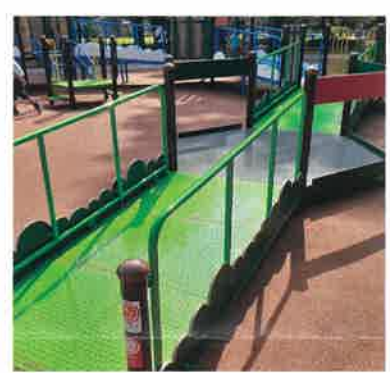
写真は世田谷区きぬた公園 安心安全のゴムチップ舗装
