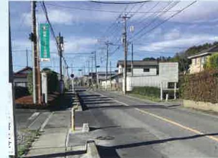
⑬ 川越入間線(堀兼地内)
