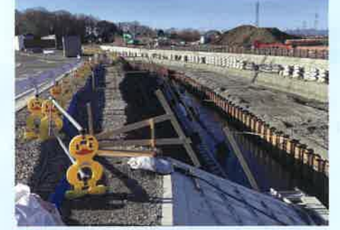
⑯ 不老川(石橋付近)
