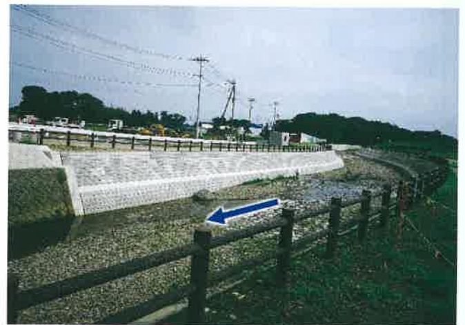
石橋上流完了状況
