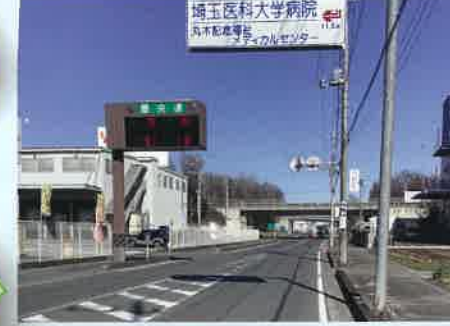
⑪ 日高狭山線(根岸地内)
