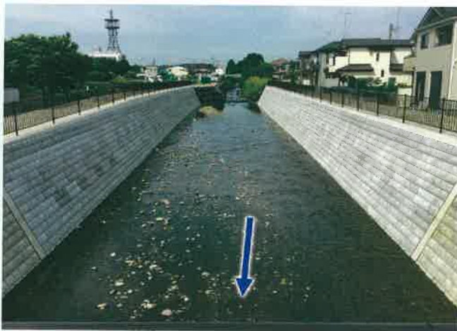
人道橋上流部完了状況
