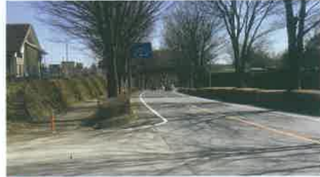
⑦ 根岸堀兼線(柏原地内)
