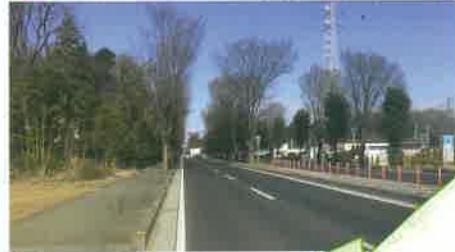
⑧ 所沢堀兼狭山線(堀兼地内)
