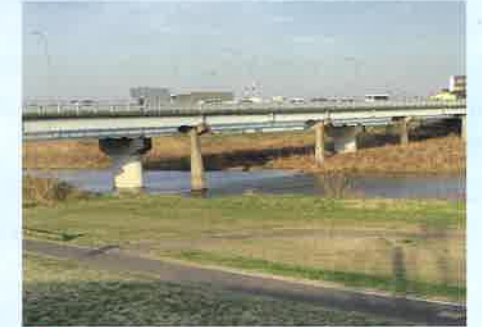
⑱ 入間川(昭代橋上流)
