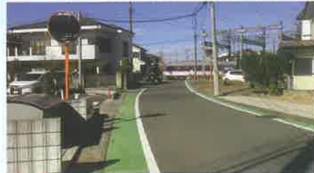
② ③ 中新田入間川線(西武線踏切付近)
