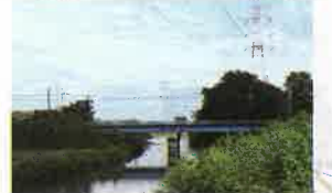
橋りょうの架け換えに向け準備が進められています。
