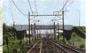
跨線橋の橋りょう修繕(断面修復、ひび割れ補修工事)が行われました。
