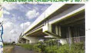
跨線橋の橋りょう修繕(橋脚補強、落橋防止工事)が行われました。
