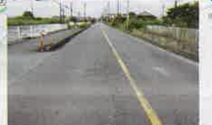
傷んだ箇所の舗装修繕が行われています。
