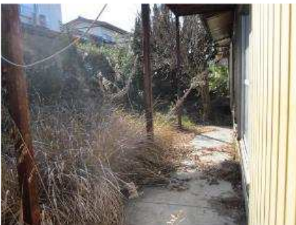
雑草が繁茂した空き家
