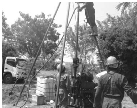
写真 ボーリングの様子
