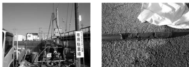
図 掘削風景と採取した地質試料
