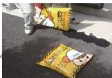
袋から出して敷きます
