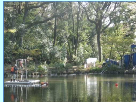
工事名:学習院血洗の池しゅんせつ工事 工事場所:東京都豊島区目白 発注者:学校法人学習院
