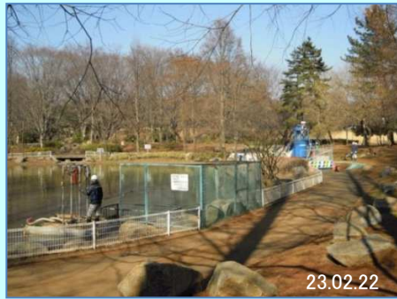
23.02.22 工事名:公園等施設補修工事(修景池浄化業務委託) 工事場所:所沢航空記念公園/埼玉県所沢市並木 発注者:埼玉県川越県土整備事務所
