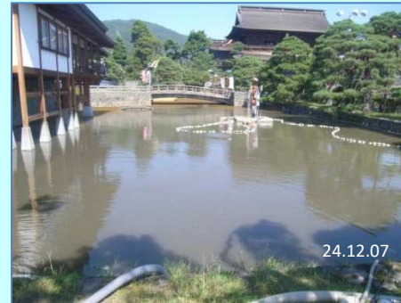
24.12.07 工事名:善光寺大勧進放生池(南側)しゅんせつ工事 工事場所:長野県長野市元善町 発注者:善光寺大勧進
