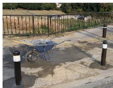
⑥ 施工完了
