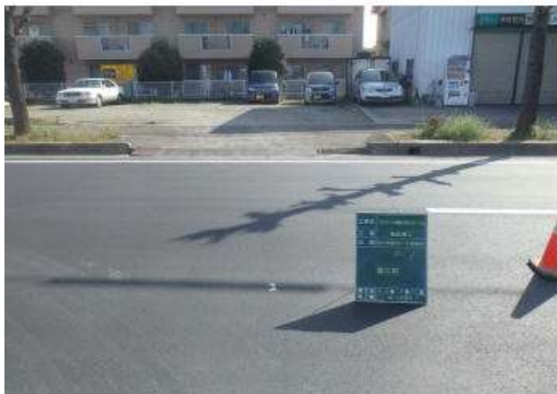
舗装工事後施工前
