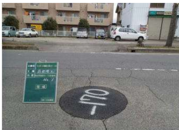
前処理工復旧完成
