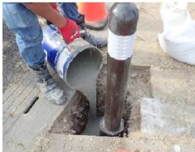
⑤ 無収縮モルタル打設
