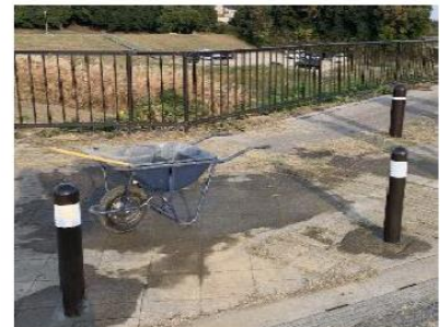
⑥ 施工完了
