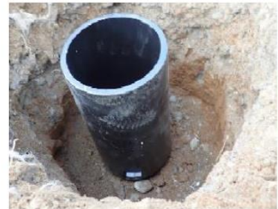
③ ヒノダクパイプ打ち込み完了
