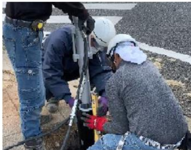
② ヒノダクパイプ打ち込み
