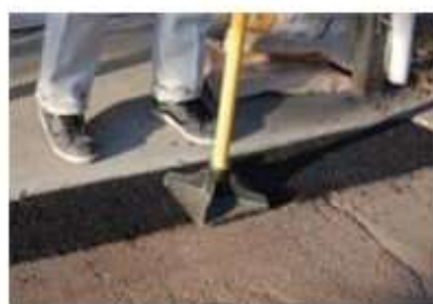
上から転圧します
