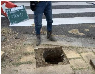
① 人力掘削 (□300×H400)
