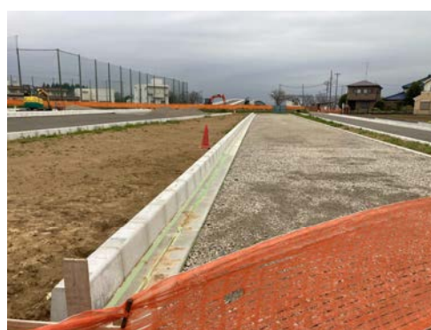
国道254号バイパス 志木工区
