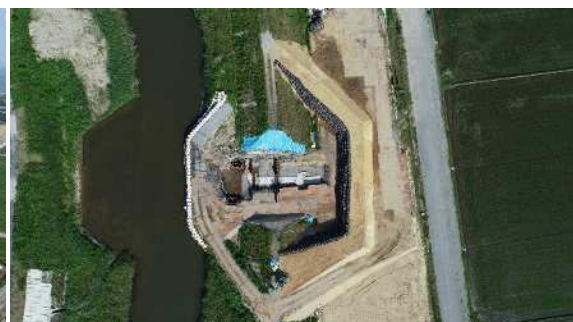
原発被害により着手が遅れた排水樋管工事
