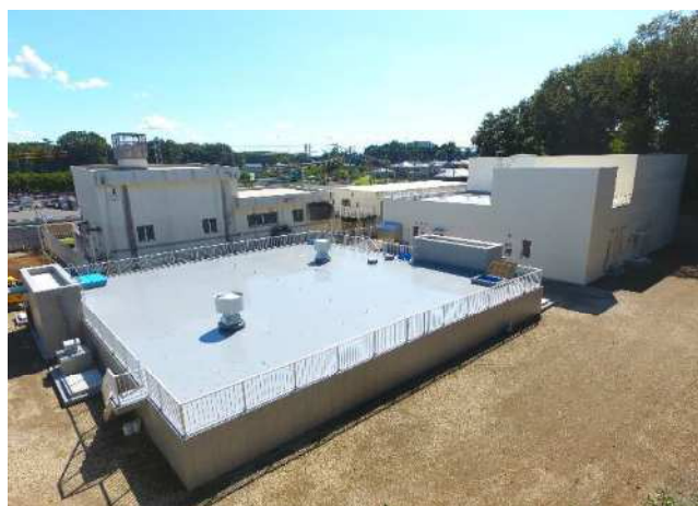
中継ポンプ所施設能力増強
