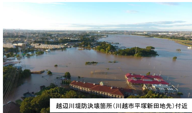
令和元年東日本台風による浸水状況
