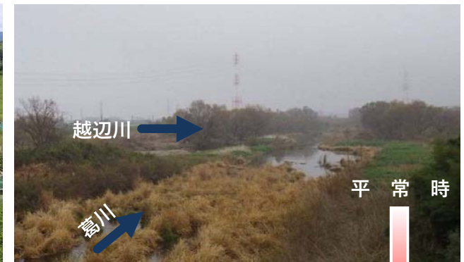
越辺川（葛川水門から下流部）
