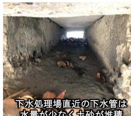
下水処理場直近の下水管は水量が少なく土砂が堆積
