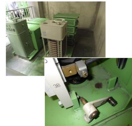
■ 老朽化により内部部品が固着・故障
