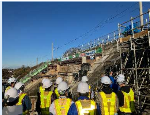
作業構台から施工状況を見ながら
