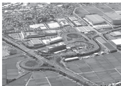
豊かな田園環境と調和した産業基盤 （圏央道 川島インターチェンジ北側地区）
