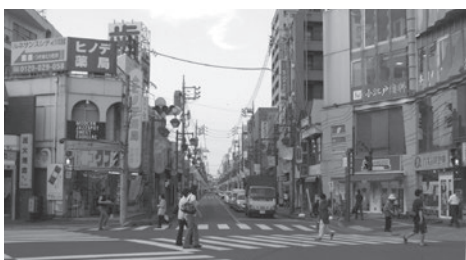
無電柱化実施前
