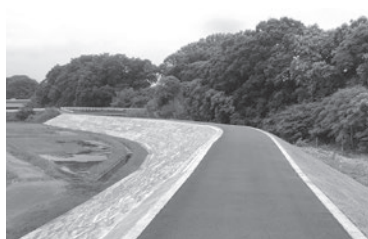
新江川(復旧後)
