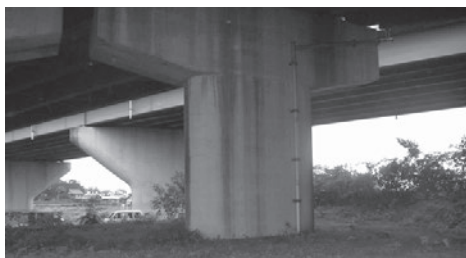
耐震補強施工前
