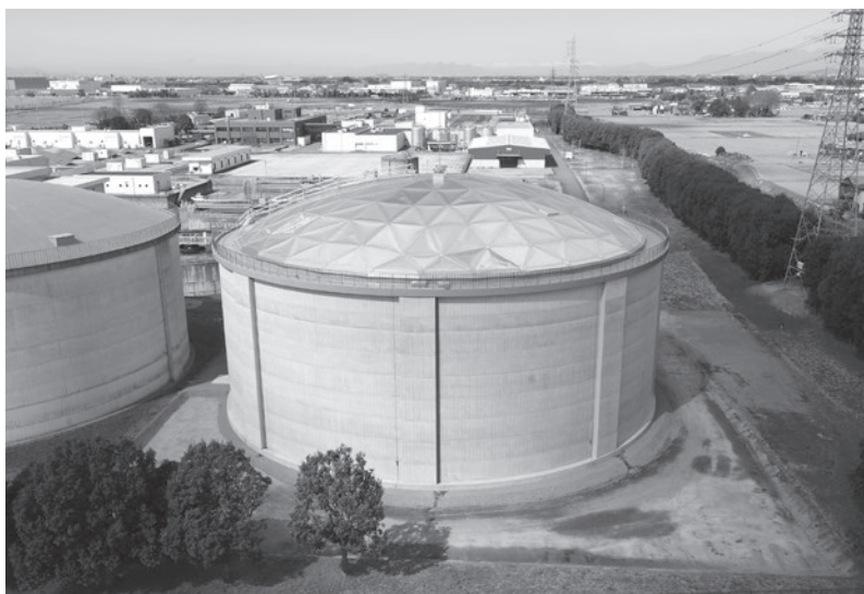
浄水場の貯水タンク (PC浄水池)
