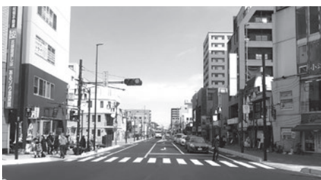
無電柱化実施後
