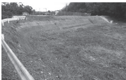
農地防災事業（ため池堤体補強）施行前
