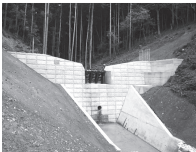
滝山・満開沢砂防堰堤(ときがわ町)
