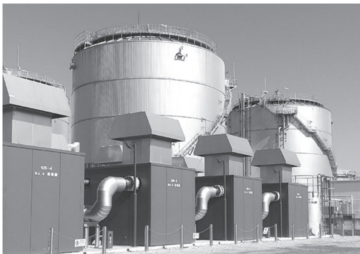
汚泥消化タンク・バイオガス発電施設
