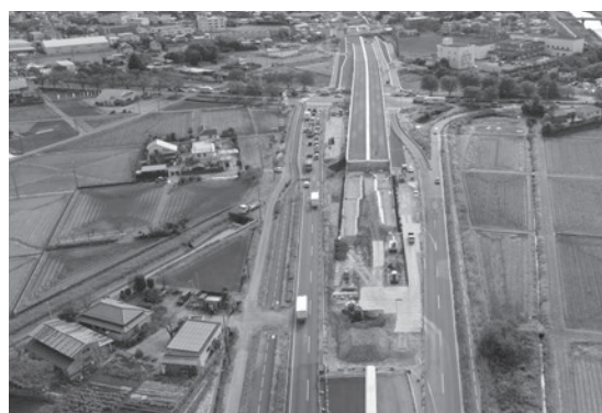
国道254号と国道463号との交差点 整備状況(富士見市)
