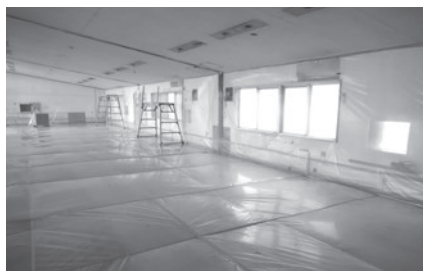
石綿飛散防止対策の実施状況 (隔離養生)
