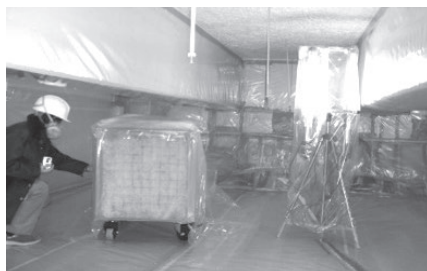
石綿飛散防止対策の実施状況 (隔離養生)
