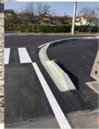
巻き込み部施工完成図
