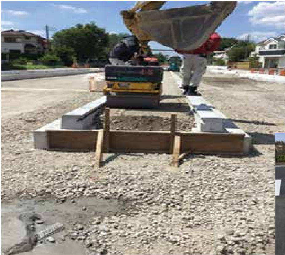
中央分離帯施工状況
