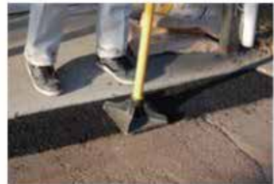
上から転圧します
