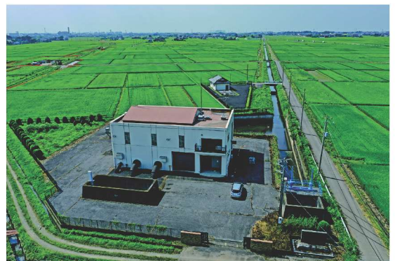
▲ 九尺排水機場外観
