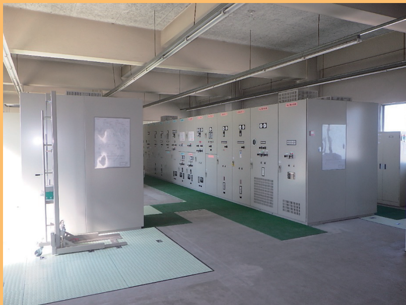
■ 柿木浄水場 2系電気設備取替工事（令和3年2月完成）
