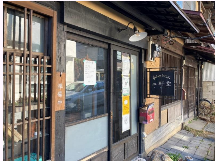
麻利（あさり）弁天長屋1階の二軒堂。弁天横丁エリア
