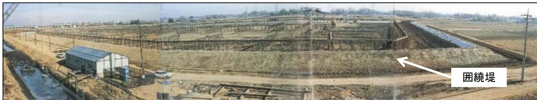
囲繞堤内全景
