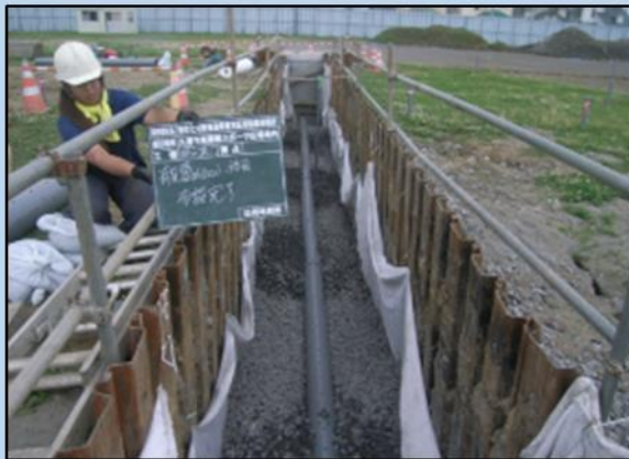
排水溝施工の様子
