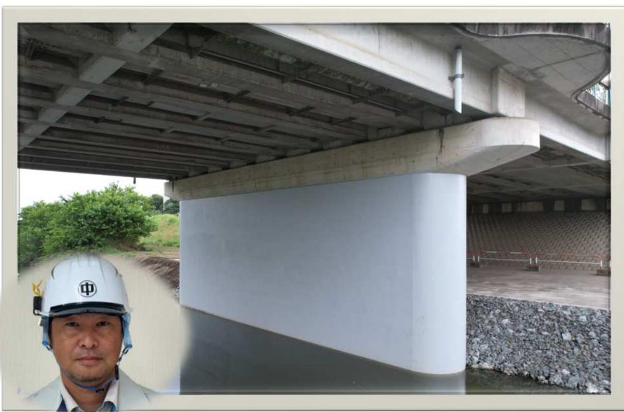
この工事は、主要地方道保谷志木線の新河岸川を渡河する「いろは橋」において、P 2 橋脚の耐震補強工事を PCM 卷立工法により施工したものである。
