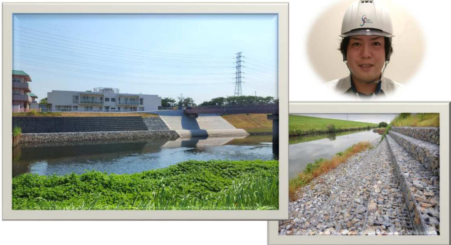
この工事は、一級河川新河岸川の治水安全度向上のため河道拡幅及び護岸工を実施したものであり、多種多様な護岸タイプと法勾配を施工する現場であった。
