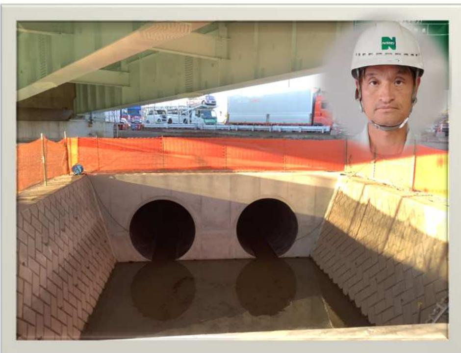
この工事は、国道254号和光富士見バイパスを整備するにあたり、計画道路を横断する南畠大排水路の函渠化工事及び国道463号さいたま方面から国道254号川越方面へ向かう切回し道路の撤去工事を行ったものである。
