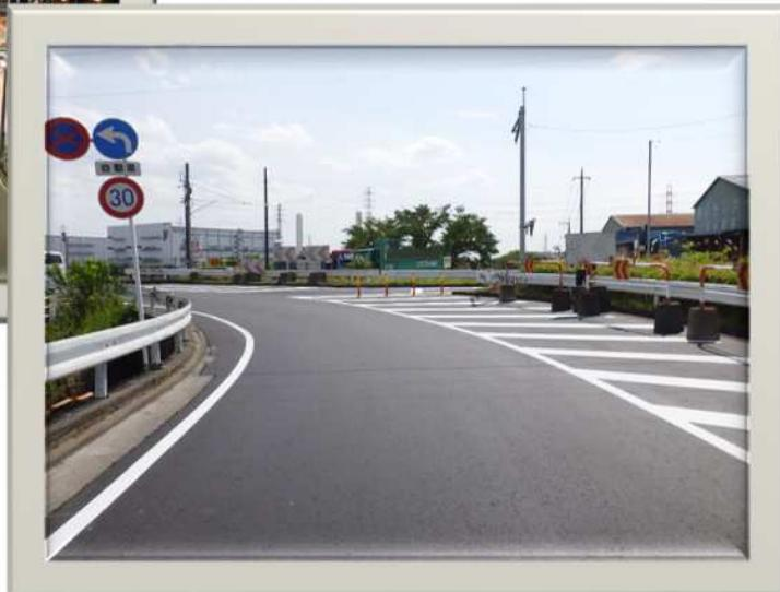
この工事は、国道254号と国道463号を結ぶ英インターチェンジのBランプ区間において、老朽化した舗装を切削オーバーレイにより修繕したものである。
