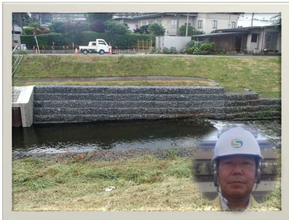
この工事は、令和元年台風第19号によって発生した、河川堤防崩壊箇所の復旧を行ったものである。
