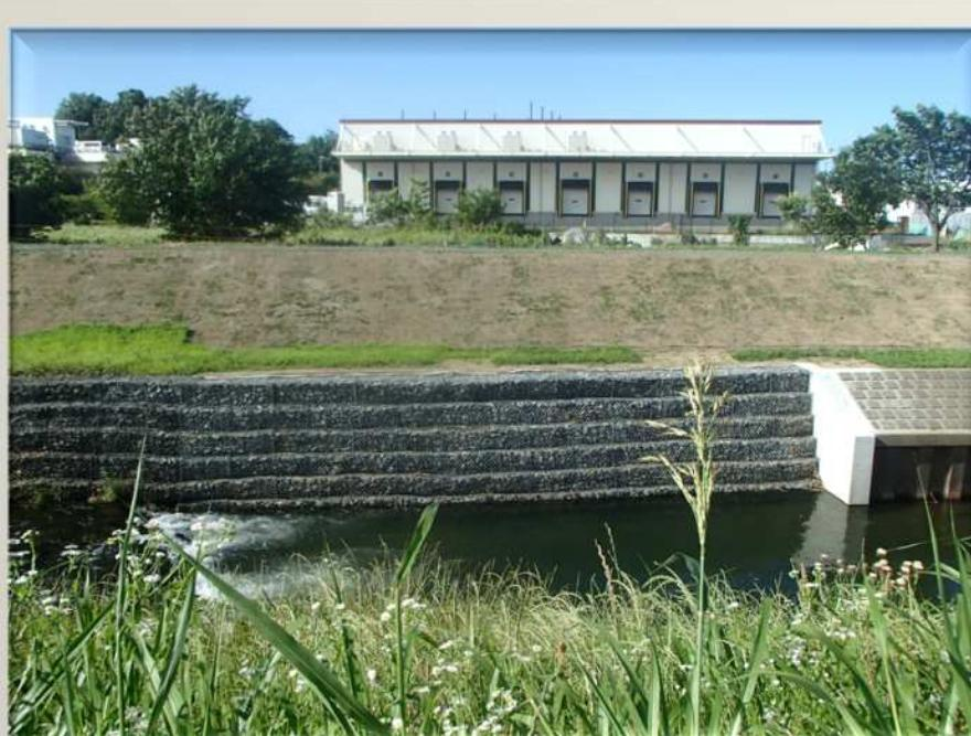
この工事は、令和元年台風第19号によって発生した、河川堤防崩壊箇所の復旧を行ったものである。
