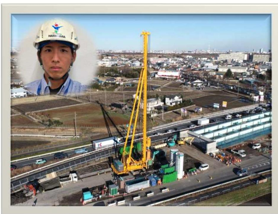
この工事は、国道254号和光富士見バイパスが国道463号を跨ぐ跨道橋の取付道路整備に当たり、地盤が軟弱なため、道路や交通の荷重に耐えられるよう、深層混合処理工法による地盤改良を行ったものである。
