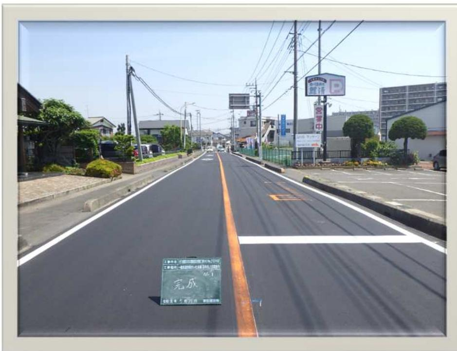
この工事は、一般県道宗岡さいたま線の老朽化した舗装を切削オーバーレイで修繕を行ったものである。
