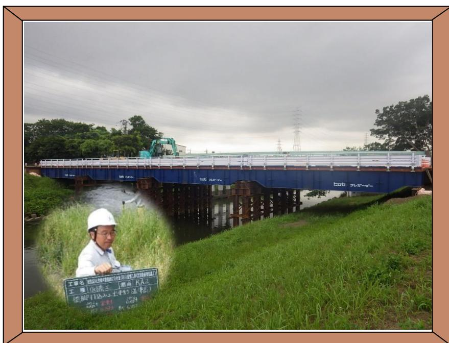
本工事は市道橋の架換前に架設する、切回し道路兼用作業構台の建設工事であり、和光市との協定締結に時間を要し、出水期迄の短い期間での施工となった。
