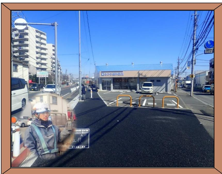
本工事は、主要地方道保谷志木線の交差点整備に係る歩道整備とともに排水構造物、舗装を施工し、安全性と通行の快適性を向上させる工事である。
