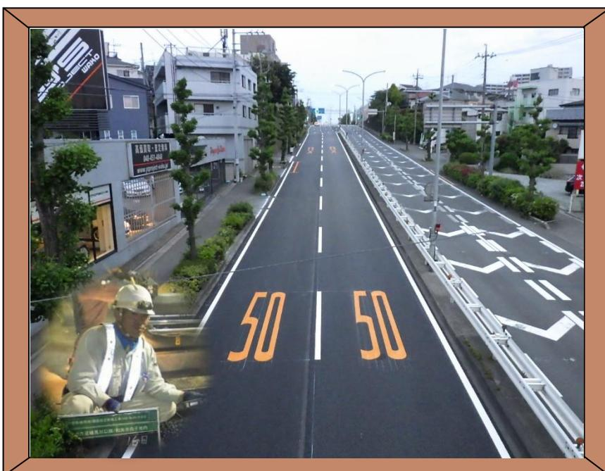
本工事は、交通量の多い主要地方道練馬川口線の老朽化した舗装を切削オーバーレイで修繕したものである。
