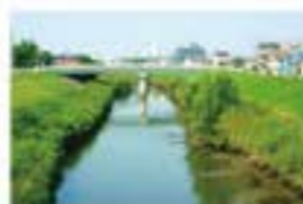
下水道整備後の川
