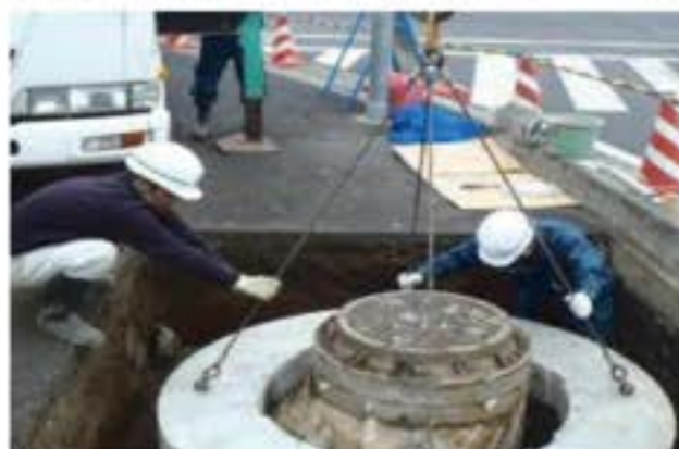
マンホールの耐震化
