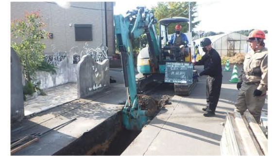
汚水の管渠工事
