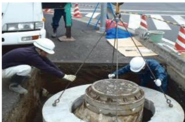
マンホールの耐震化
