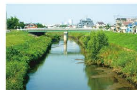
下水道整備後の川
