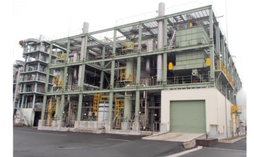
固形燃料化施設
