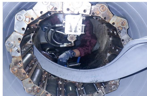
管渠の補修工事
