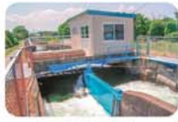
くしげのうみ 深谷市 橋換用水(深谷市) (分水工:水の量を分ける施設)
