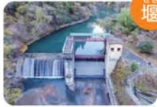
おがのうみ 小鹿野用水頭首工(小鹿野町)
