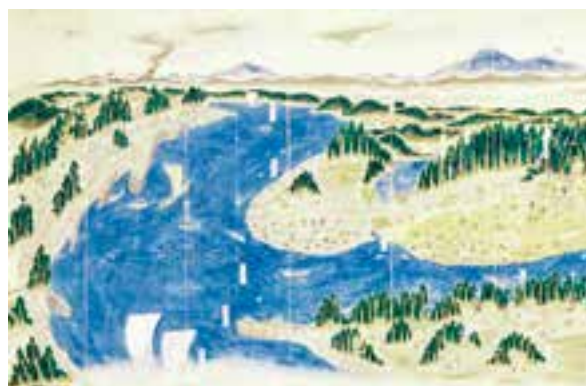
利根川の流を変える工事
