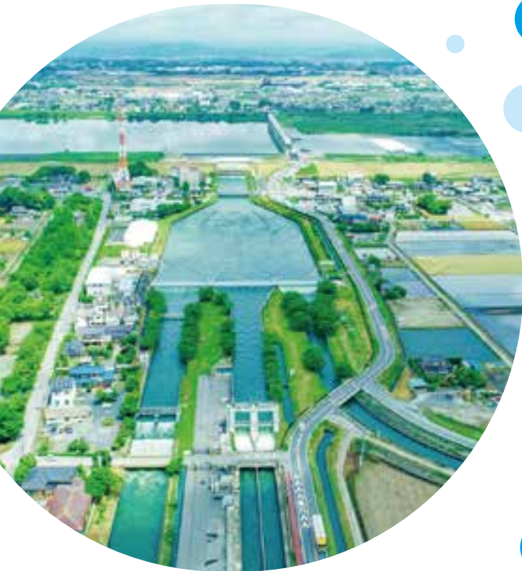
とね どうすいる ぜんけい 利根導水路全景
