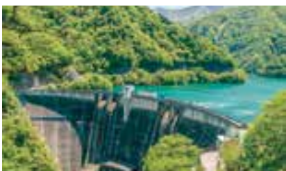
ふたせ ちちぶし 二瀬ダム (秩父市) (アーチ式ダム)
