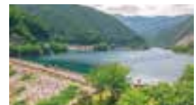
②有間ダム(飯能市) (ロックフィルダム)
