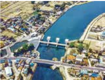
ふるとねぎき こしがやし まつぶしまち 古利根堰 (越谷市・松伏町)
