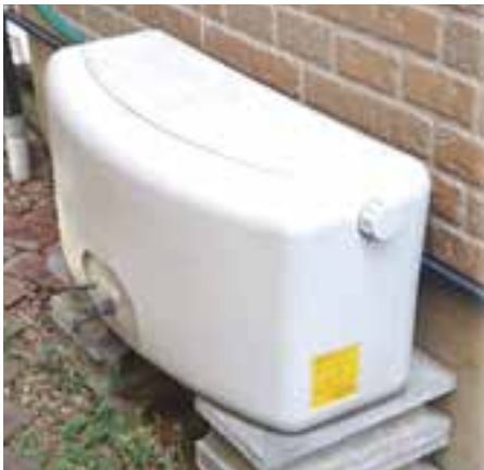
家庭用雨水タンクの設置例
