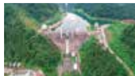
①合角ダム(秩父市・小鹿野町) (重力式コンクリートダム)
