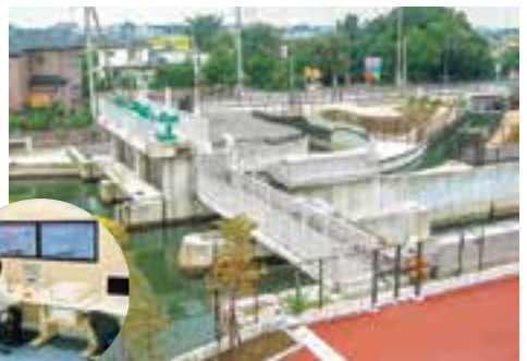
コンピュータで管理される琵琶溜井分水工（久喜市・幸手市）
