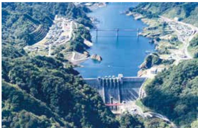
ハッ場ダム(群馬県長野原町)
