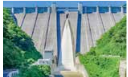
うらやま ちちぶし 浦山ダム (秩父市) じゅうりょくしき (重力式コンクリートダム)
