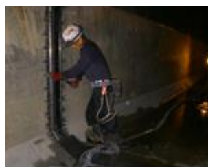
函渠継手部の耐震化
