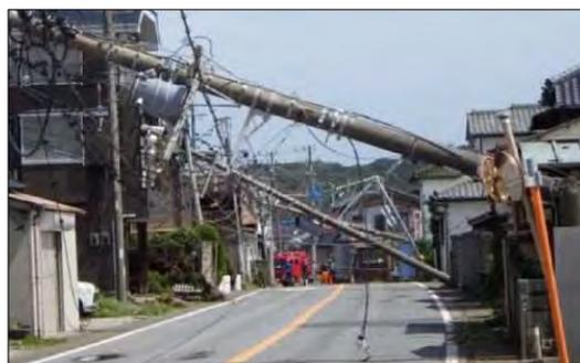
令和元年房総半島台風による電柱倒壊
