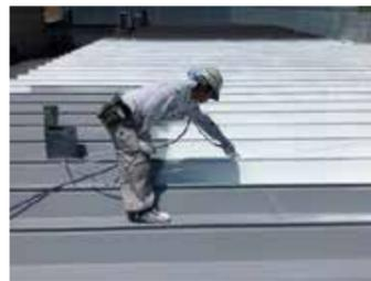
飛散が少ないスプレー施工で工期短縮
