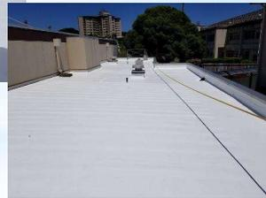
小型電動エアレスプレーにて防水材を塗布
