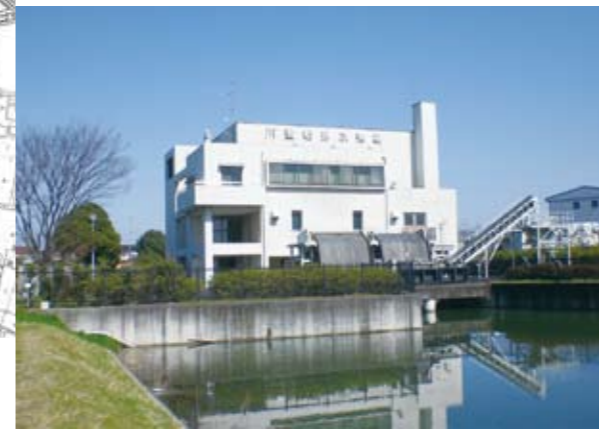
川妻給排水機場 (茨城県五霞町)
