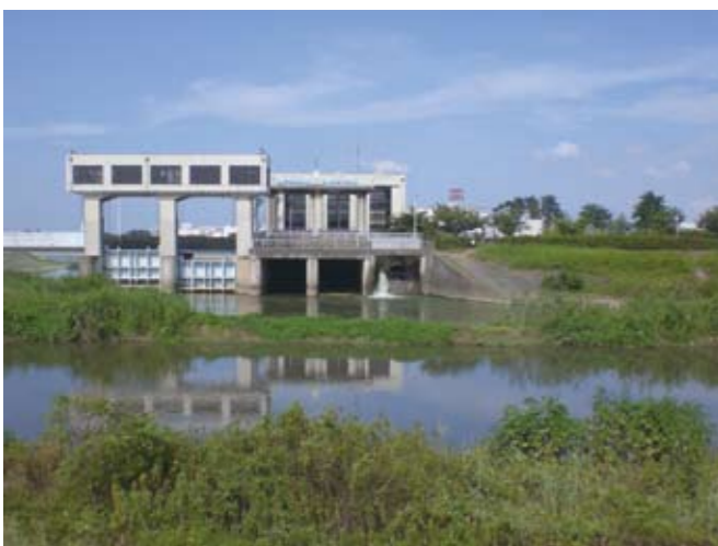
放流ゲート・行幸給排水機場（中川側から） 調節池の水を中川に放流します
