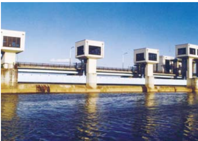
越流堰・貯水ゲート（中川側から） 中川の洪水が調節池に流入します
