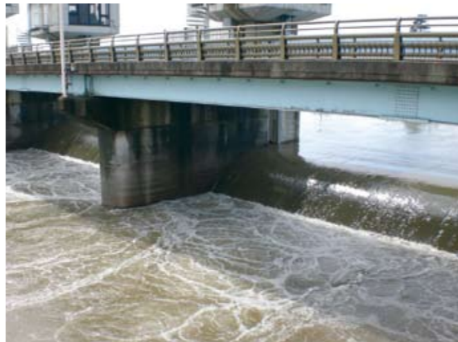
洪水調節（中川から調節池へ流入中）
